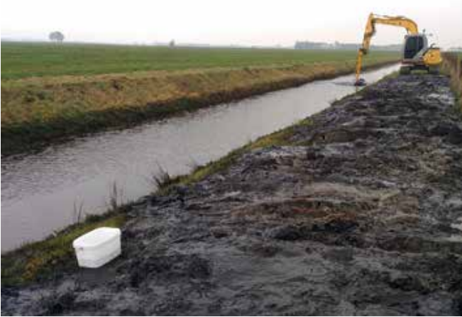
Het heeft de voorkeur om de bagger uit te spreiden en met de bovenkant van de slootbodembodem boven te leggen en niet om te draaien. (Foto's: Arthur de Bruin)
